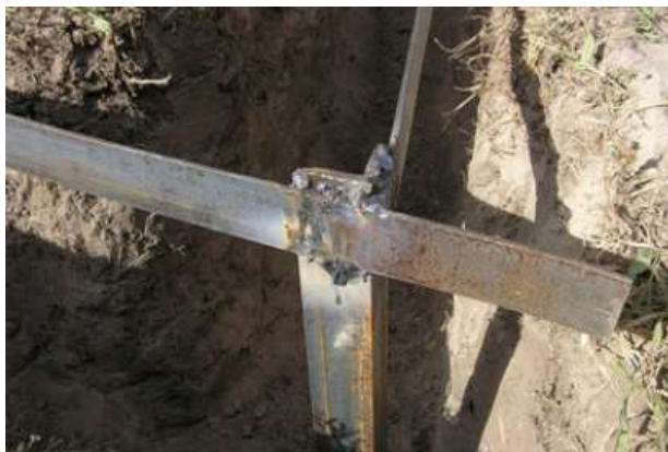
Рис. 4.6. Монтаж контуру заземлення КТП
