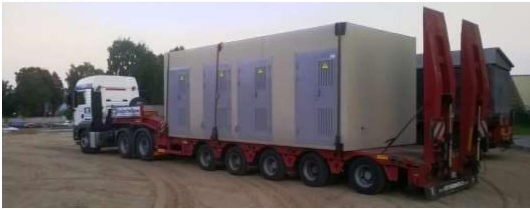
Рис. 4.2. Доставка КТП до місця установки
