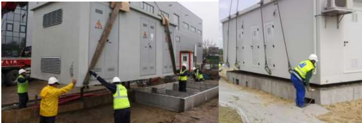
Рис. 4.3. Установка та фіксація трансформаторної підстанції на фундаментних блоках
