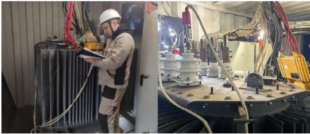
Рис. 4.7. Приймально-здавальні випробування КТП після монтажу
