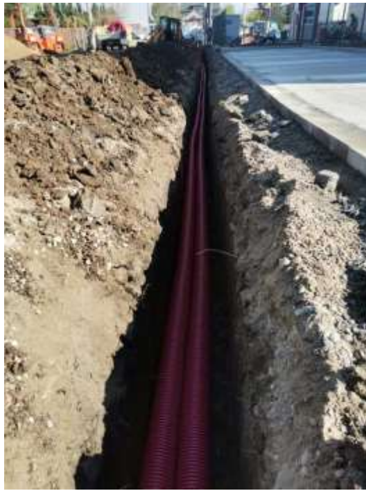
Рис. 4.5. Прокладання силових кабельних ліній
