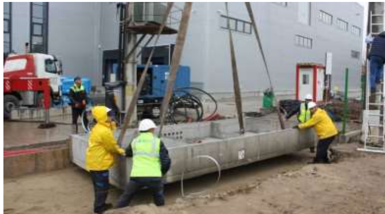
Рис. 4.1. Приклад установки фундаментного блоку для монтажу КТП
