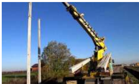
Рисунок 4.3- Установка залізобетонної опори за допомогою бурильної машини із домкратом
