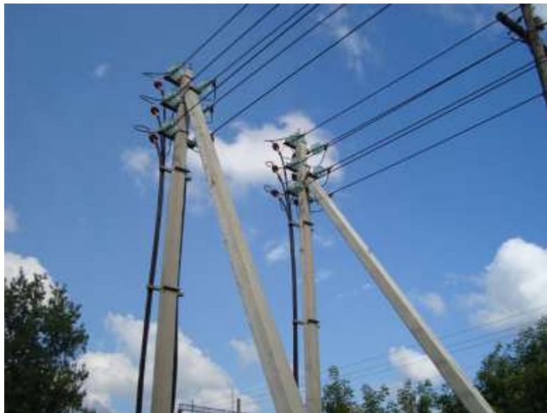
Рисунок 4.2- Монтаж лінії 0,4 кВ.
