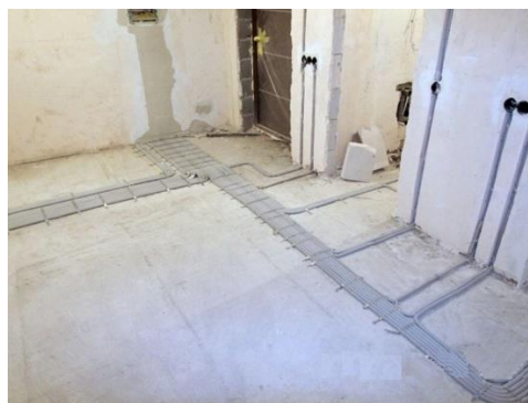
Рисунок 2.4 – Прокладка проводки в трубах по підлозі
