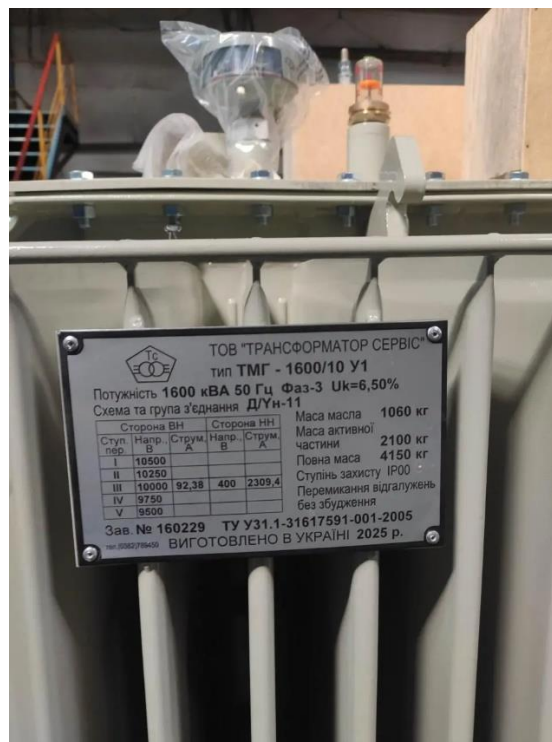
Рисунок 3.2 – Трансформатор ТМ (ТМГ)-1600/10У1
