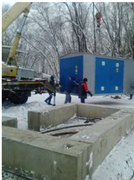
Рис. 4.4. Транспортування ТП до місця виконання монтажних робіт
