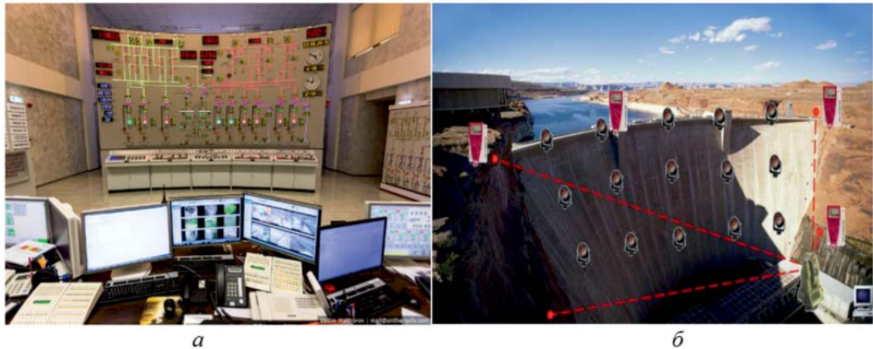
Рис. 1. Пульт управління Кременчуцької ГЕС (а) та розміщення КВА у греблі Канівської ГЕС (б)
