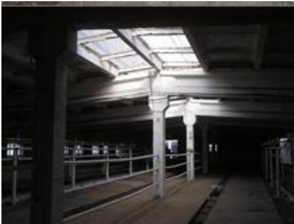
Рисунок 3.27. Додатковий «ліхтар» виготовлений на даху корівника
