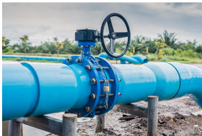
Рисунок 1.8 – Фотографія дросельного клапана
