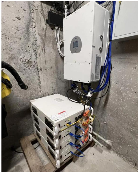
Рис. 2.2 - Гібридний інвертор Deye SUN-6K-SG03LP1-EU з акумуляторною система зберігання енергії
