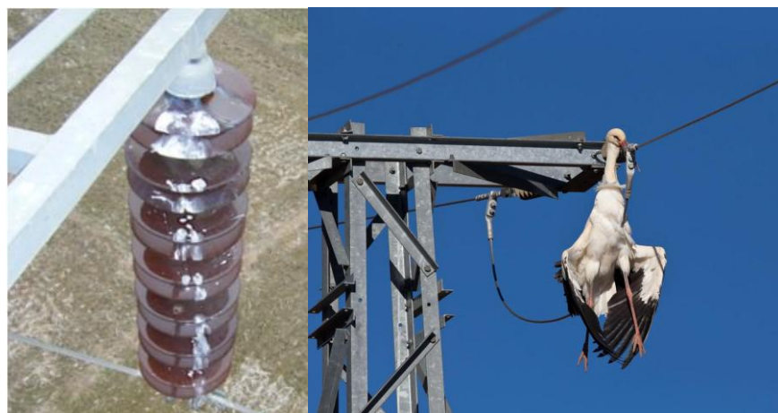
Рис. 1.4 – Вплив птахів на зниження рівня ізоляції ЛЕП
