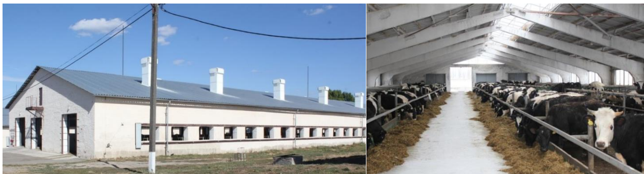
Рисунок 3.1 – загальний вигляд будівлі молочно-товарної ферми
