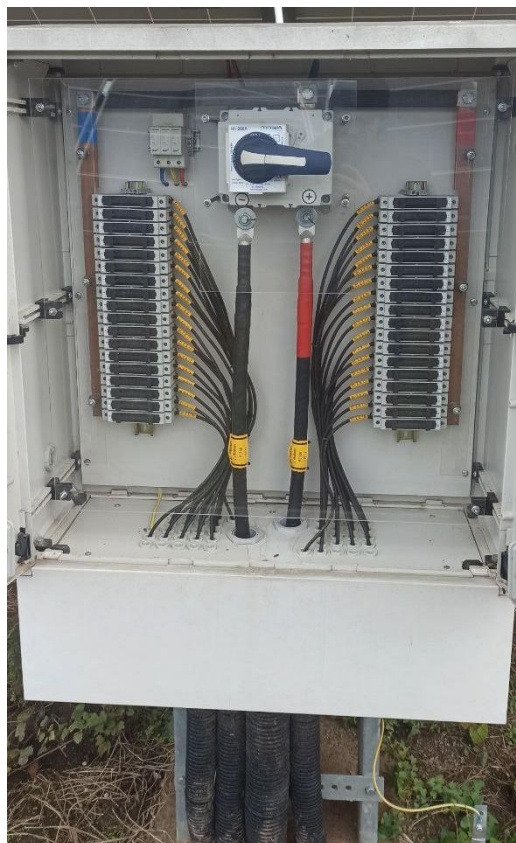
Рис. 2.3 – Зовнішній вигляд ящика з'єднань
