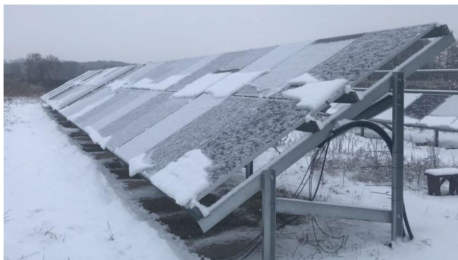
Рисунок 1.3 – Вплив сніжного покриву та морозу на сонячні панелі
