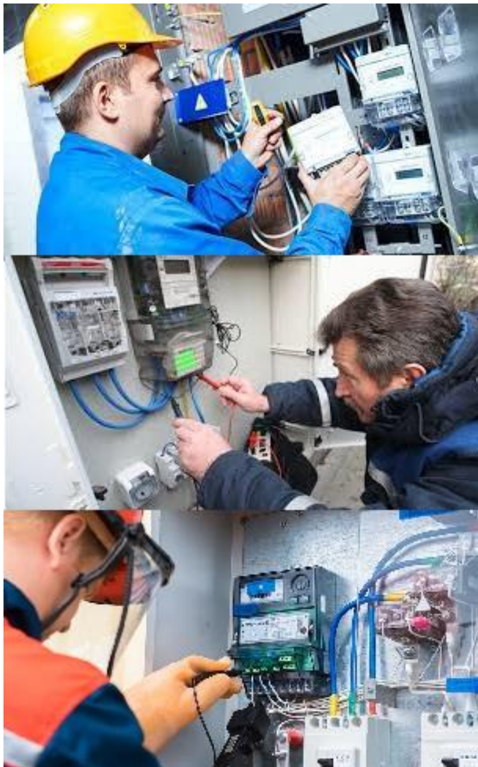
Рисунок 2.1. Повірка лічильників без демонтажу для лабораторних умов
