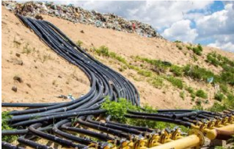
Рисунок 2.2 – Схема збору біогазу
