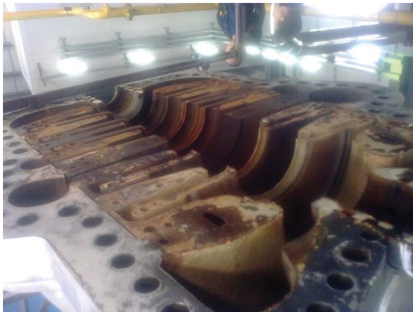
Рис. 6. Нижняя часть корпуса центробежного компрессора после долгих лет эксплуатации.
