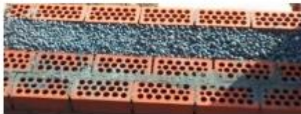
Рис. 4. Конструкція стіни з використанням керамзиту
