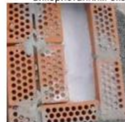
Рис. 5. Конструкція стіни з використанням перліту
