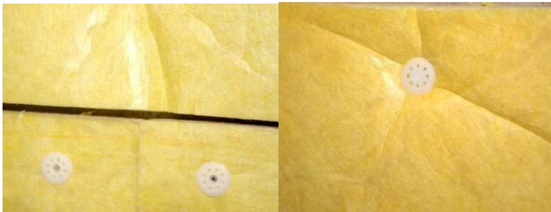
Рис.3.3- Приклади , які не допускаються при виконанні роботи утеплення
