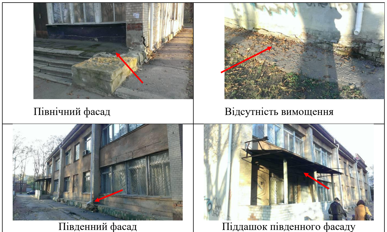
Рис.1.11-Фото будівлі до реконструкції
