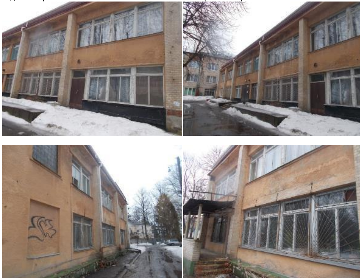
Рис. 1 Будівля до капітального ремонту
