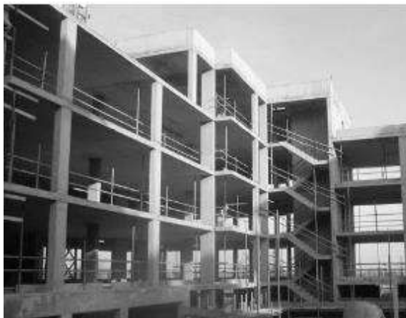
Рис.1 Будівля з монолітним каркасом
