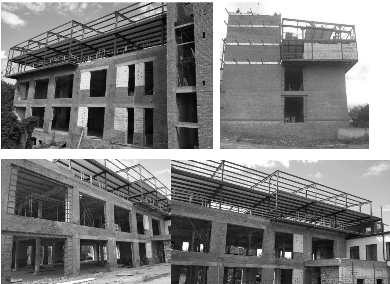
Рис. 1 Будівля до реконструкції
